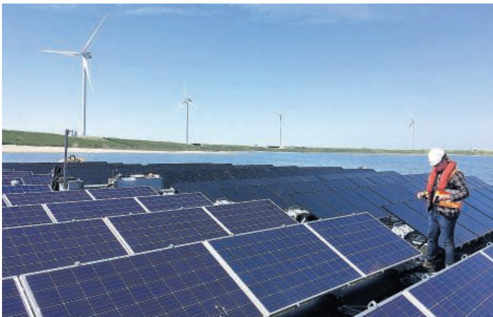
Een medewerker van Floating Solar inspecteert de zonnepanelen op de Slufter in de haven van Rotterdam. beeld Floating Solar
