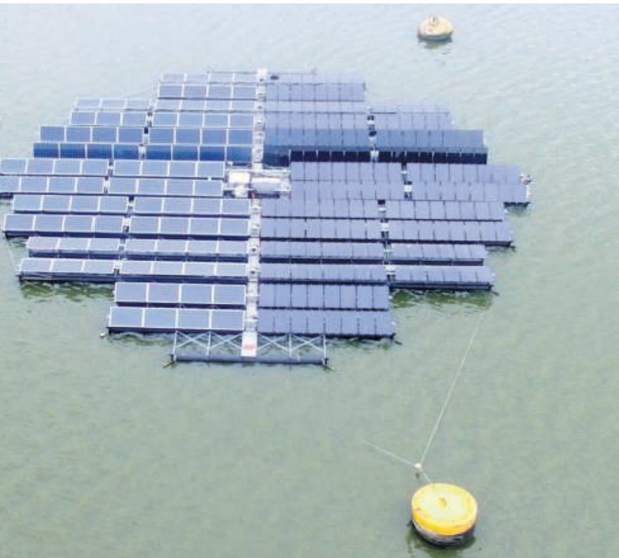
Floating Solar uit Rhenen bedacht een zonne-eiland. Het wordt op z'n plek gehouden met kabels aan boeien die in het water drijven. Ook maakt dit systeem het mogelijk om het eiland te laten meebewegen met de zon. beeld Floating Solar
